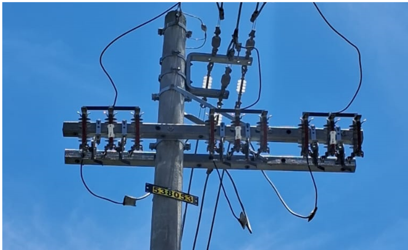
Figura 1 - Base Religadora na Rede com a presença do Koala
